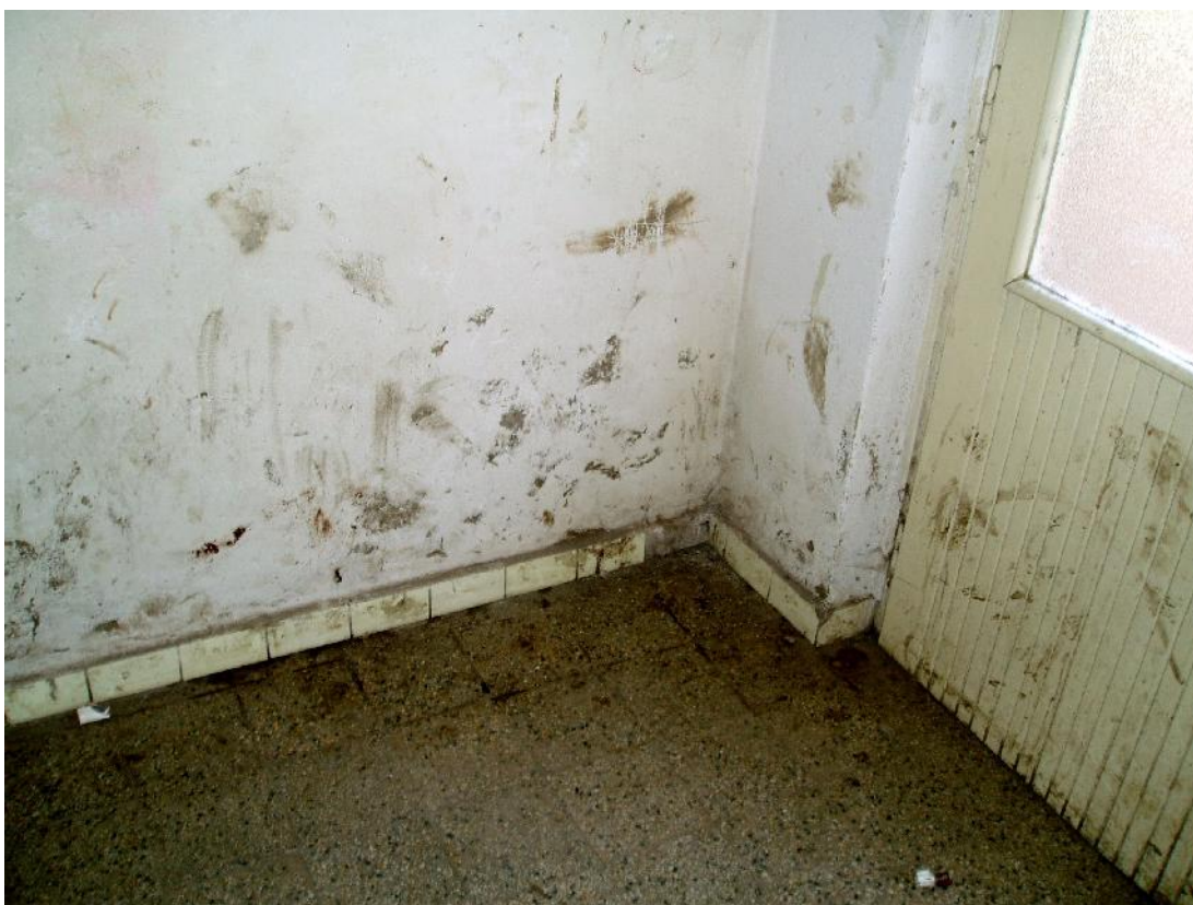
PŘÍLOHA VI – Ubytovna Výšiny, vstupní dveře
